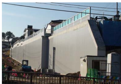
図一参 2.14 完成壁面(化粧パネル)
