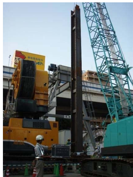
図一参 3.15 芯材建込み状況
