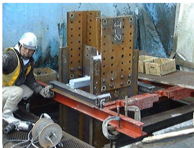
図一解 3.4.16 下部 NS-BOX の仮受け状況
