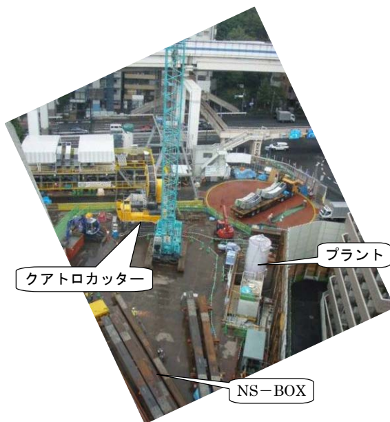
図一参 3.14 作業ヤード] 状況
