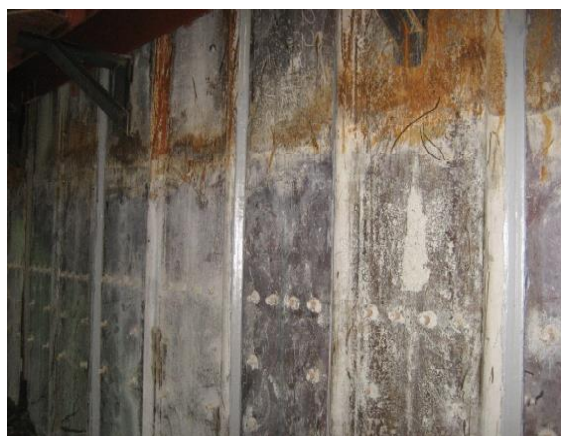
止水処置後の壁面（全体）
