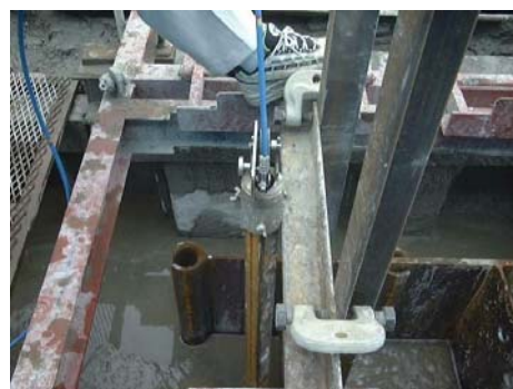
図一解 3. 4. 10 傾斜測定状況
