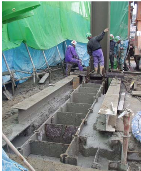
図一参 2. 12 NS-BOX 建込み状況
