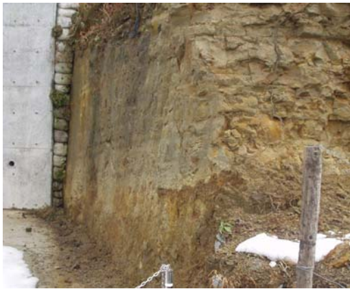
図一参 2. 10 掘削対象地盤(風化砂岩)
