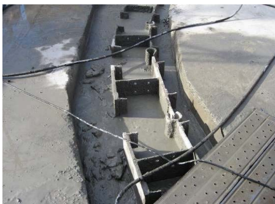
図一参 3. 11 建込み完了状況 「鋼製地中連続壁協会」資料による
