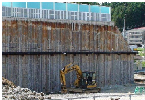
図一参 2. 13 掘削後の鋼製連壁
