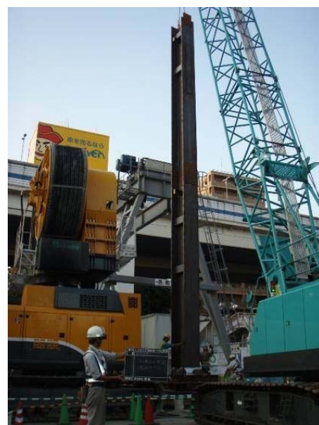
図一参 3.15 芯材建込み状況
