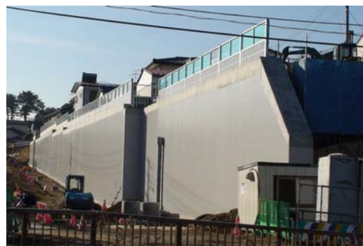
図一参 2. 14 完成壁面(化粧パネル)
