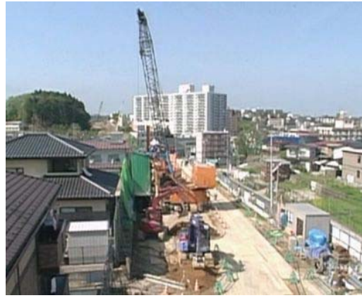
図一参 2. 11 近接施工状況
