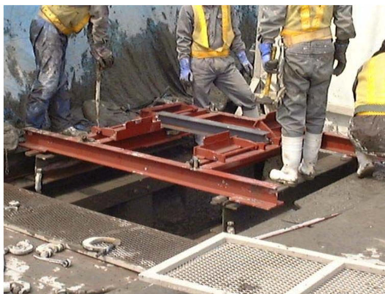
図一解 3. 4. 5 建込み定規設置状況
