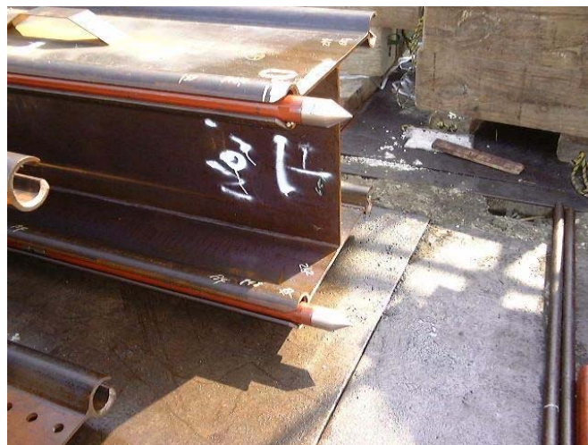
図一解 3. 4. 24 防護パイプ事前挿入状況
